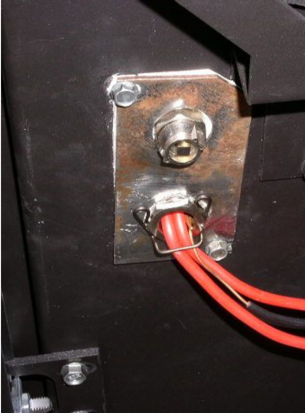
Abbildung 5: Bild zeigt Entlüftung und Tauchhülse mit Fühleranschlusspaket am Wodtke Pellet-Primäröfen
