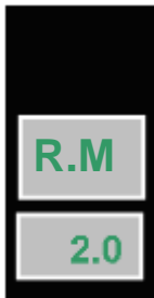
Abb. 23: Anzeige Punkt für rauchgasseitige interne Modulation
